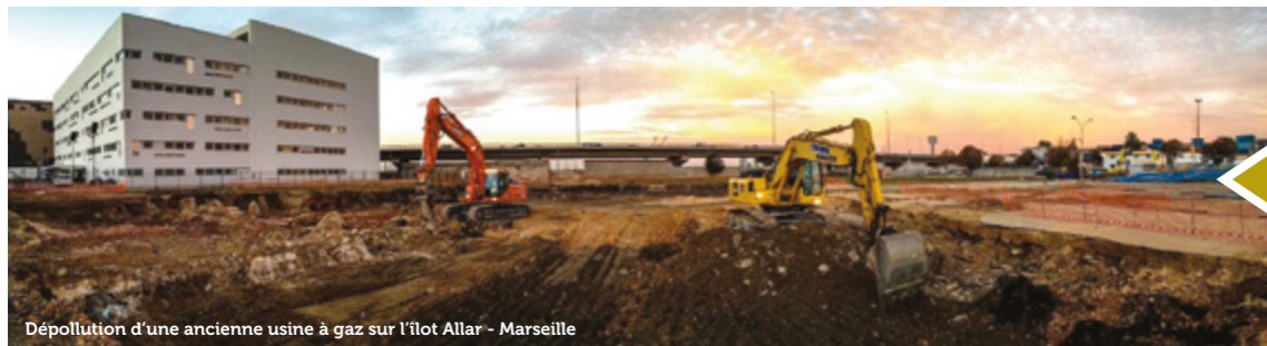
Dépollution d'une ancienne usine à gaz sur l'îlot Allar - Marseille
