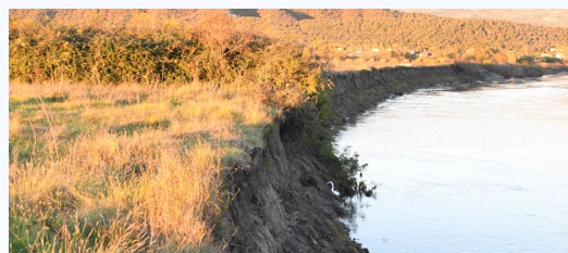
Restauration des berges de la rivière Kiri (Shkodër)
